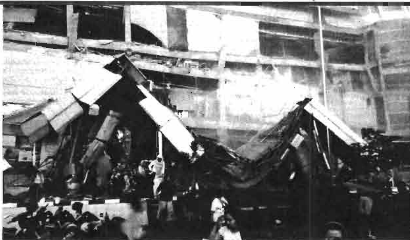
UN CENTRO COMERCIAL derrumbado en Palu, isla de Célebes, ayer.
