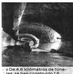
De 4.6 kilómetros de túneles, se han construido 1.6.
