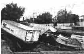
Accidente. A un costado del predio donde se alza la plaza Encuentro Oceanía se abrió un socavón de 400 metros cuadrados y 10 de profundidad.
