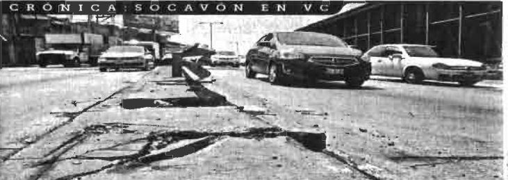
Los vecinos indican que los hundimientos empezaron con la construcción de una plaza.
