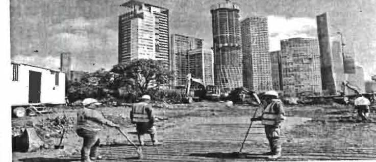
En el parque, creado con 2 mil millones de pesos de la IP, inició la segunda etapa de obras.
