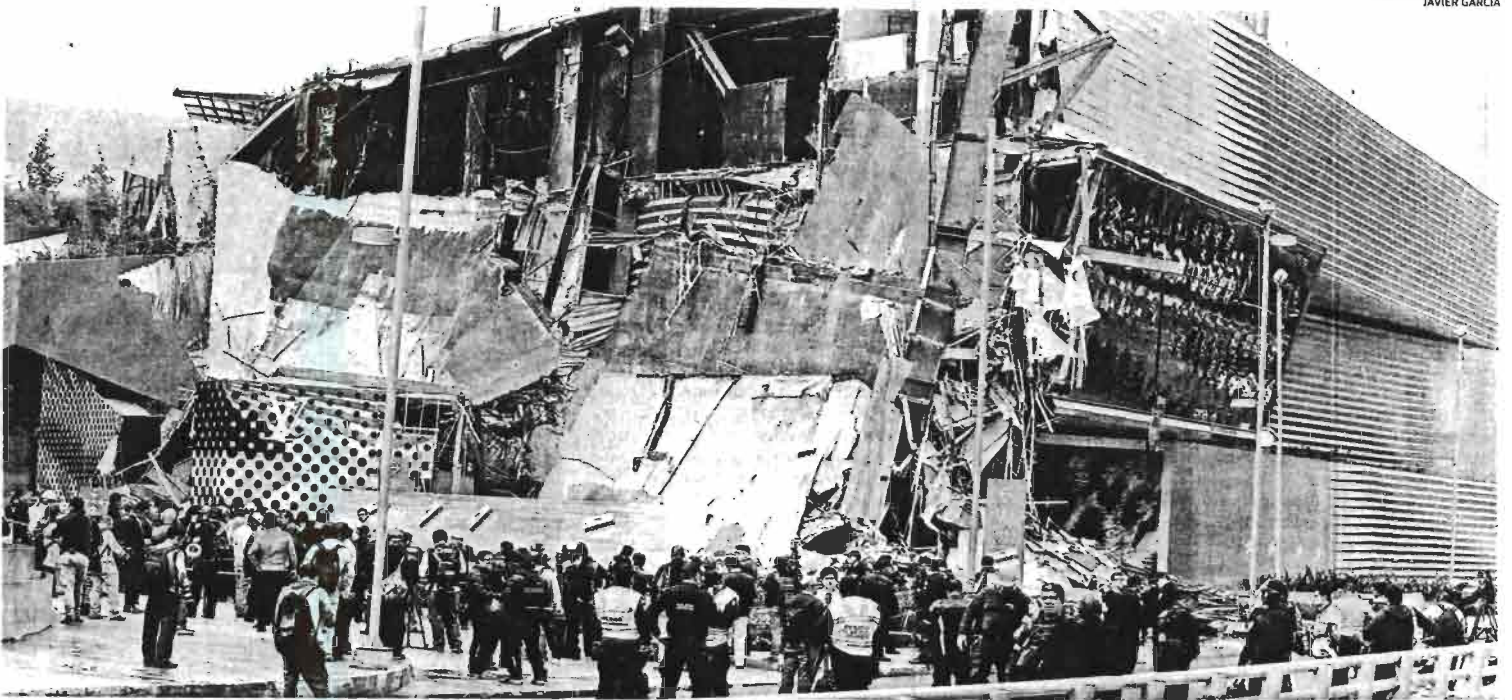
El centro comercial fue inaugurado apenas en marzo pasado; cuatro meses después una de sus fachadas se derrumbó.
