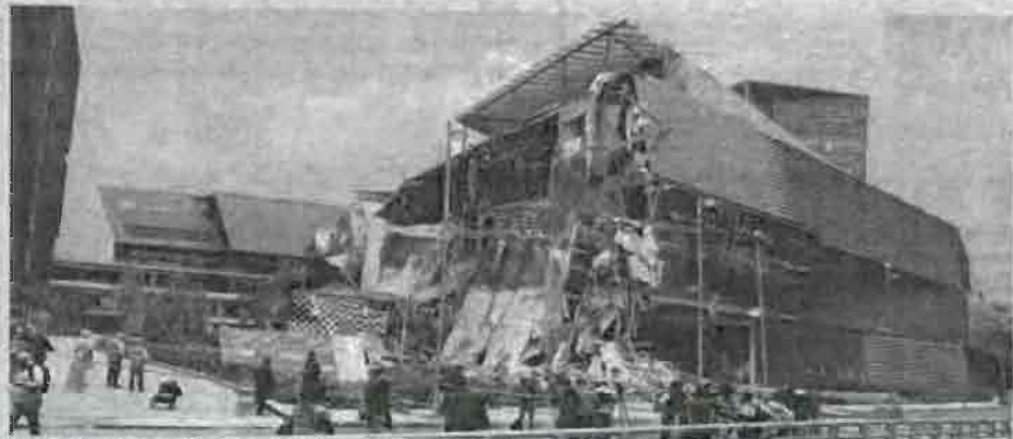
Abrimiento de los 11.8 metros de ayer se registró el derrumbe de una tarima colada, en una zona que se encontraba en obra y que sería utilizada para oficinas.
