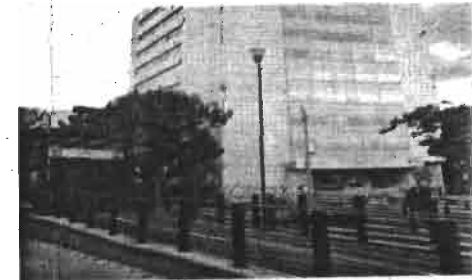
El riesgo latente del edificio de La Morena 804 mantiene cerrada la estación Etiopía del Metrobús desde el 19 de septiembre.
