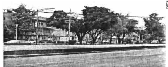
A lo largo de 1.1 kilómetros se habilitará una pista de dos carriles con material granular de hule para amortiguar el paso de los deportistas.
