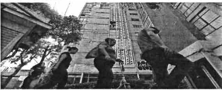
El inmueble deshabitado presenta daños, desde hace décadas, causados por sismos previos.
