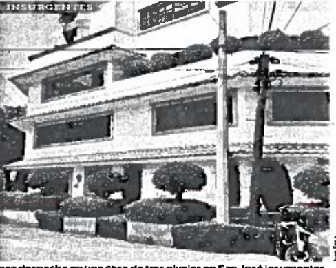
Trabajan en edificio dañado, pero titular estrena oficina
