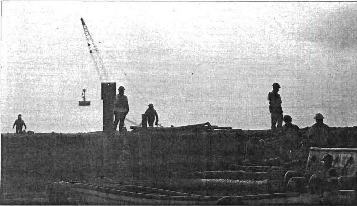
Obras en uno de los 32 muelles que están siendo construidos en Veracruz. / MÓNICA GONZÁLEZ
