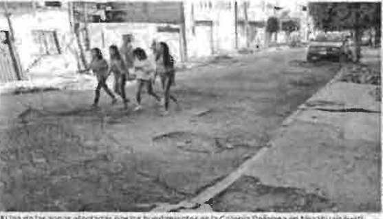
Una de las zonas afectadas por sus hundimientos en la Colonia Reforma en Nechalcoyotli
