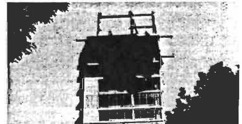
El desmantelamiento de la estructura de los pisos excedentes se realizará con mazos y sopletes.
