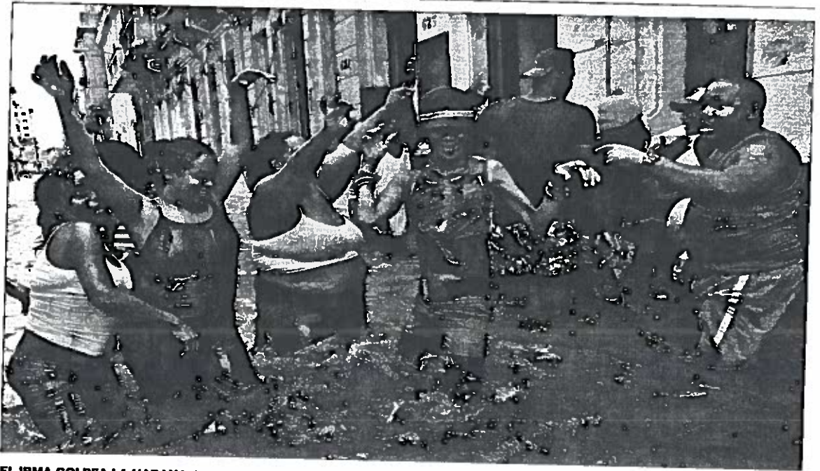
EL IRMA GOLPEA LA HABANA. La capital cubana sigue en condiciones dramáticas y en la oscuridad, a pesar de que el Gobierno de Raúl Castro lleva días afrontando las labores de reconstrucción. En su paso por La Habana, el Irma derrumbó más de 1.000 casas y dañó otras 3.000, provocó grandes inundaciones y mató al menos a 10 personas. En la imagen, varios cubanos bailan en el agua. / R. PUJOL (EFE) PÁGINA 12
