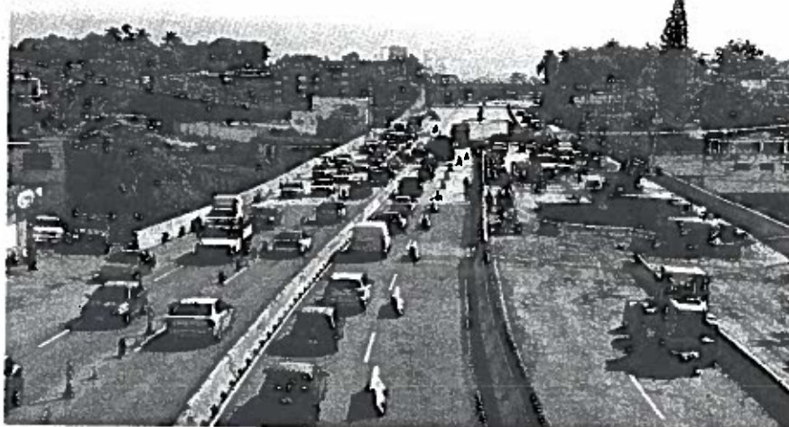
El sobrecosto de la ampliación de la autopista representa 40% del costo final de la obra, que fue de mil 978 mdp.
