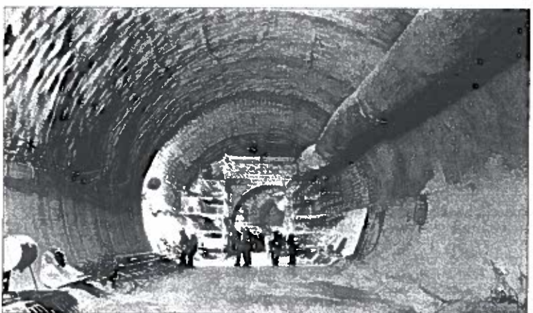
Recorrido por las entrañas de lo que será la ampliación de la Línea 12.
