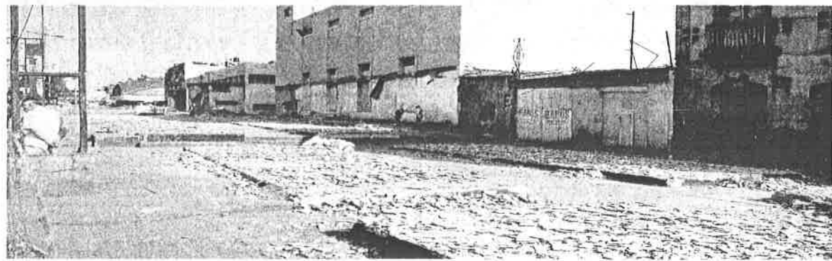
Esta semana trabajadores de la delegación Cuauhtémoc retiraron los puestos semifijos y levantaron el piso de la banqueta de Eje 1 Norte.
