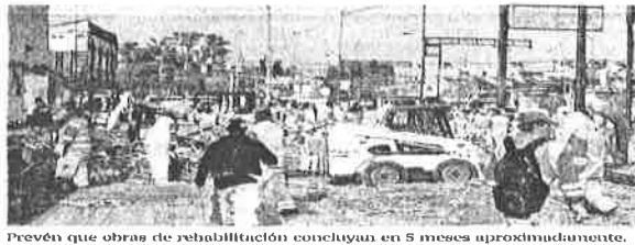
Prevén que obras de rehabilitación concluyan en 5 meses aproximadamente.
