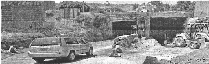
La ampliación del túnel, donde habrá dos carriles de circulación, es la única con avances.
