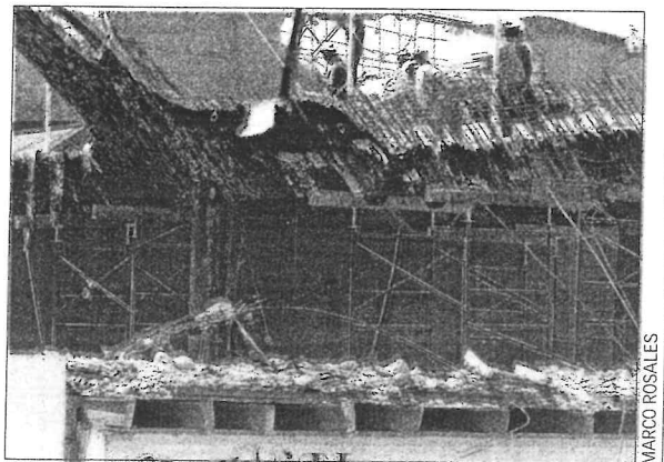
Continúan las obras, pese a que tenían que estar terminadas en diciembre de 2013.
