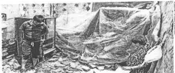
Los habitantes de la vivienda, cuyo techo se colapsó, sacaron a la calle los fragmentos de material y cubrieron con plástico algunos muebles.
