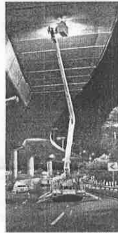
Los trabajos más tardados serán la evaluación y cambio de luminarias.
