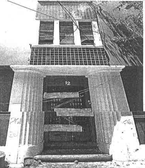
EN RESGUARDO. Al edificio invadido le fueron colocados sellos por autoridades capitalinas.
