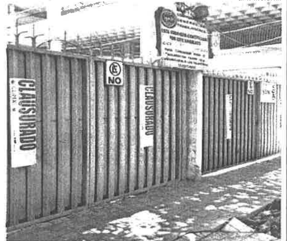
El edificio actualmente está clausurado.
