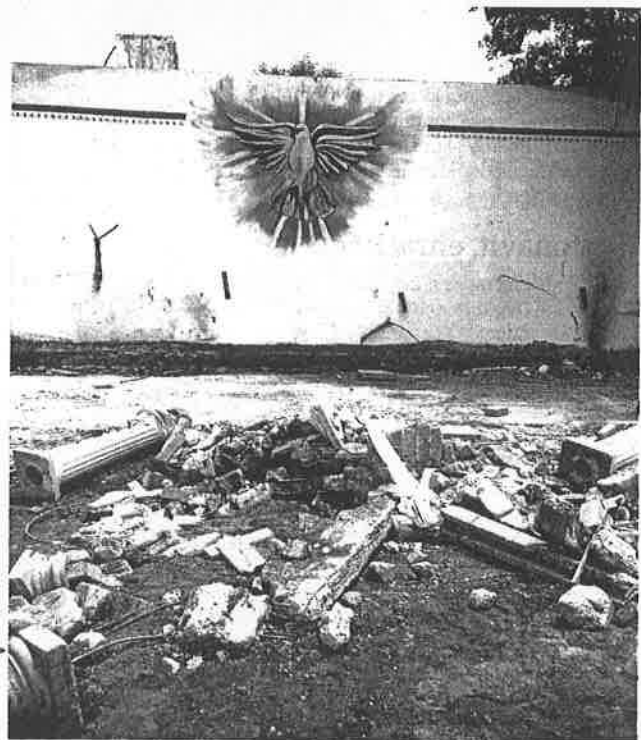
EL LUGAR donde se ubicaba la capilla, en la colonia Cultura Maya, ahora es un espacio donde sólo quedan pedazos de concreto tirados en el suelo.
