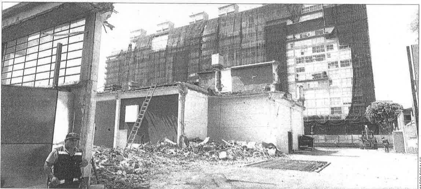
TRABAJOS. La empresa GAP Inmobiliaria derribó algunas viviendas para comenzar la construcción de las nuevas torres que se construirán en la Benito Juárez.
