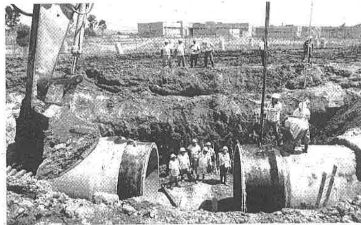
Se realizaron cambios de tubería
