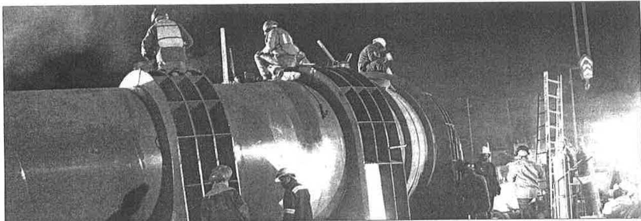
AVANCE. En la madrugada del sábado, trabajadores de la Conagua terminaron las labores de la Línea 2 del Sistema Cutzamala.
