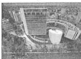
De 456 cámaras de vigilancia en todo el nuevo edificio del Senado, 40 no sirven. FOTO EE. FERNANDO VILLA DEL ANCEL
