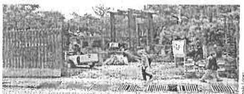
La planta de bombeo que está en obra desahogará los pozos de absorción construidos en agosto pasado.
