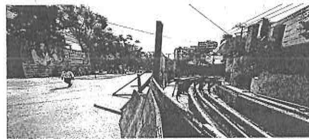
Entre los faltantes hay banquetas y registros subterráneos inconclusos; además falta instalar luminarias, señalamientos y vegetación en el camellón.
