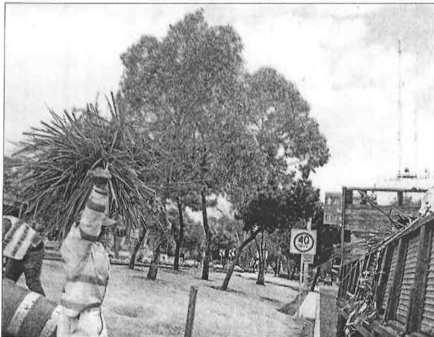
OBRA. Los trabajadores limpian la zona por donde se construirá el deprimido.
