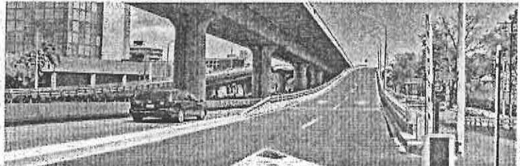
Para la construcción del tramo se utilizaron 72 columnas, 68 traves, y 206 tabletas de concreto.
