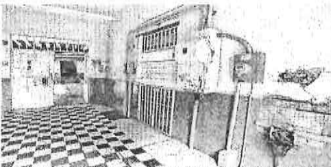
La Secundaria 11, ubicada en el Centro, tiene daños estructurales y sigue esperando mantenimiento.
