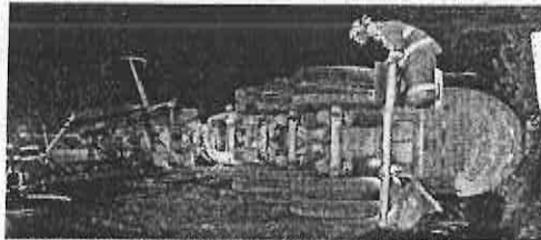
La pipa destruyó el muro de contención de la carretera México-Toluca.
