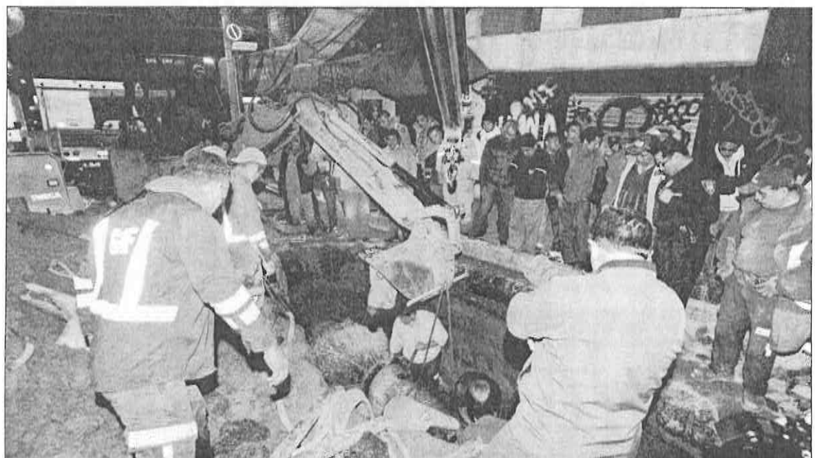
Personal de la delegación Magdalena Contreras y del Sacmex trabajaron durante 48 horas para reparar la tubería dañada por la empresa de gas natural y que provocó problemas de abasto de agua a 28 colonias de la zona ■ Foto Cuartoscuro
