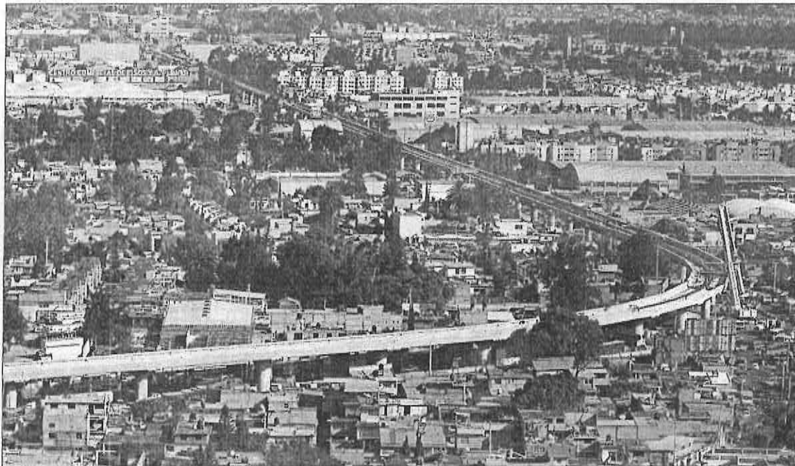
El GDF señaló que los recursos para la reconstrucción del tramo elevado de la línea 12 del Metro están garantizados ■ Foto Alfredo Domínguez
