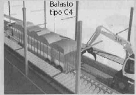
3 Antes de colocar los nuevos durmientes y rieles, el cajón será cubierto con 26 mil metros cúbicos de balasto tipo C4 (calizo).
