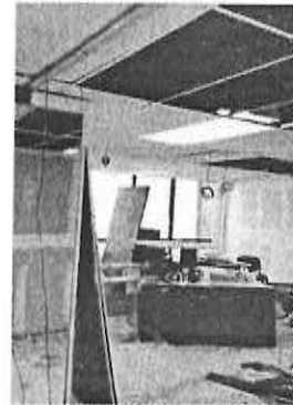
EL PISO CUATRO del edificio del PRD, en imagen del sábado.
