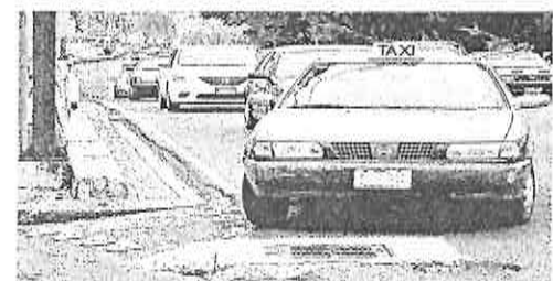
Baches y coladeras rotas representan un riesgo para conductores
