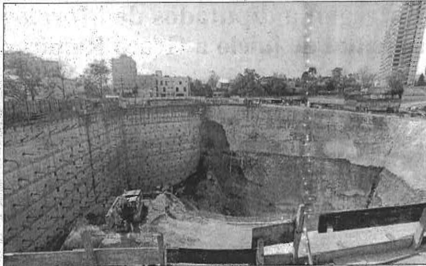
Personal de Protección Civil de la delegación Álvaro Obregón suspendió la construcción de un edificio de oficinas ubicado en Revolución y Barranca del Muerto, luego de que la mañana de ayer ocurriera un deslizamiento de tierra de 40 metros cúbicos, que cayó sobre una retroexcavadora, sin que se registraran heridos. Las autoridades delegacionales aseguraron que la obra cuenta con todos los permisos ■ Foto Alfredo Domínguez
