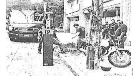
En la Colonia Extremadura Insurgentes comenzó la instalación de las bases de los parqueaderos bajo el resguardo de granaderos.
