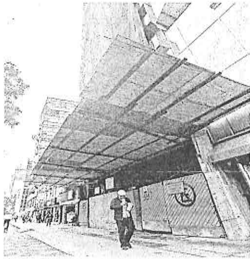
La obra ubicada en Paseo de la Reforma 380 tiene una marquesina de madera, debajo de la cual pasan los peatones.
