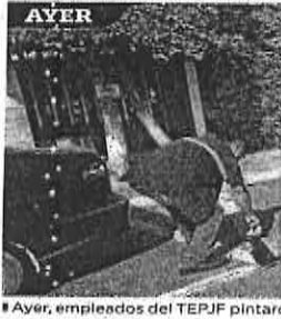
Ayer, empleados del TEPJF pintaron de negro los cajones de estacionamiento de la vialidad primaria.
