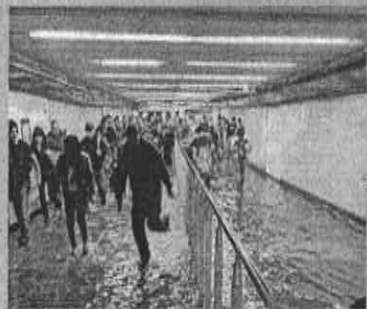
El STC realizará sellado de filtraciones e impermeabilización de techos para evitar más inundaciones
