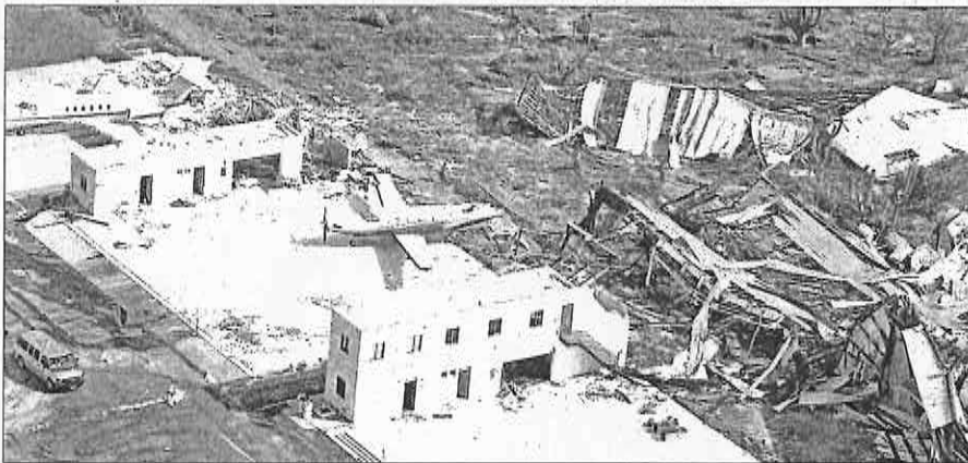
Así quedaron dos hangares del aeropuerto de Los Cabos debido al paso del huracán Odile, meteoro que abandonó ayer la península de Baja California, donde causó graves daños y dejó varados a 30 mil turistas. Degradado a tormenta, Odile cruzó el Mar de Cortés e ingresó a Sonora.
