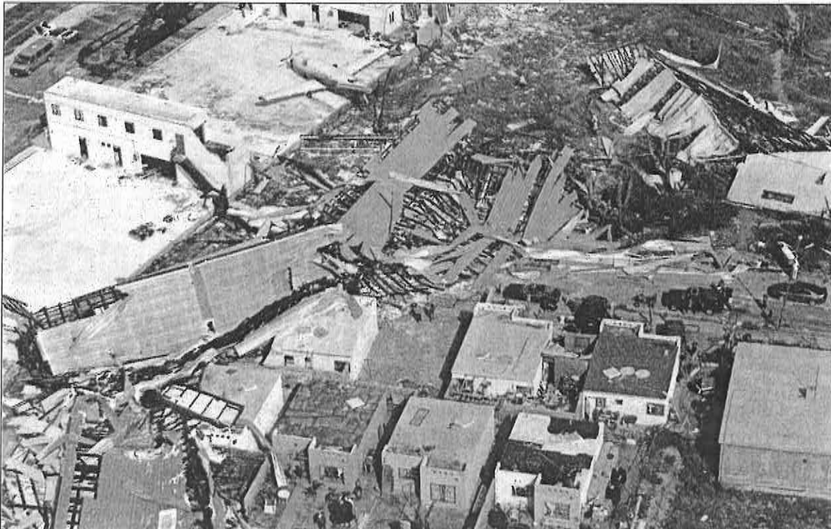
Destrucción en la colindancia del aeropuerto de Los Cabos, Baja California Sur, con zonas habitacionales. Odile tocó tierra en esta localidad el pasado domingo a las 20 horas, con vientos hasta de 205 kilómetros por hora ■ Foto Presidencia
