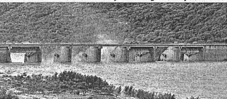
La ruptura de las compuertas de La Venta agravó los daños por la tormenta en Acapulco Diamante.
