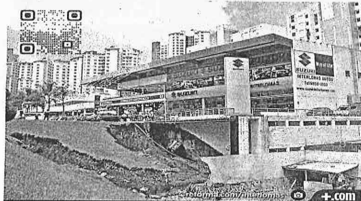
Una de las zonas más afectadas por el desbordamiento del Río San Joaquín fue la barranca que divide a Interlomas de la Colonia Ampliación Palo Solo, donde 3 autos resultaron dañados.
