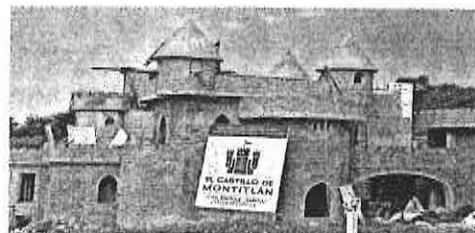
El hotel de Jorge Luis Preciado está actualmente en construcción en el Municipio de Cuauhtémoc, Colima.
