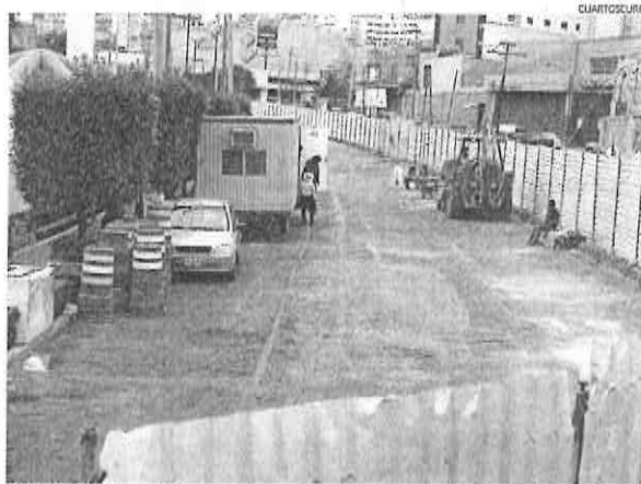
CONSTANTE. Las violaciones de uso de suelo son la falta más recurrente en la zona.
