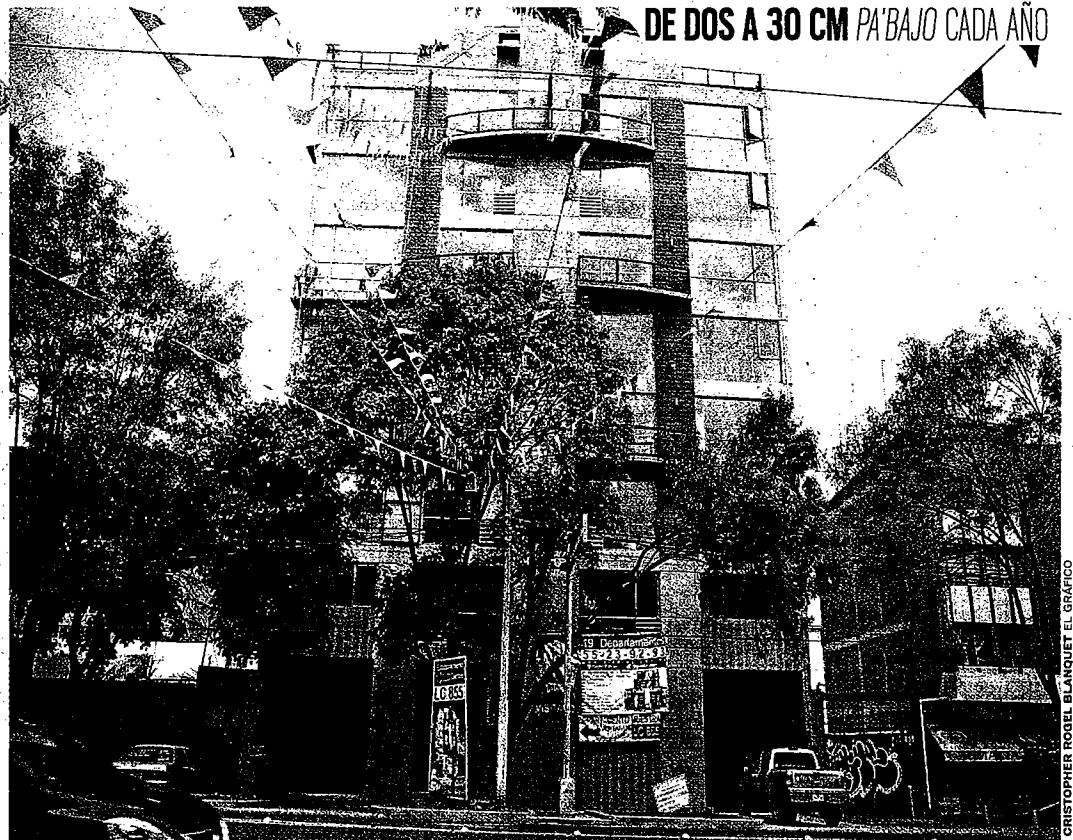
En algunas zonas se pueden apreciar edificios inclinados (como el de la foto) debido a los asentamientos que se dan en el suelo
