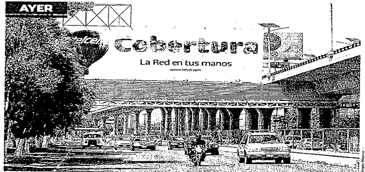
> La estructura luce con dos anuncios, uno en cada lado, con publicidad de una empresa de telefonía. Se colocaron dos columnas que apuntalan el puente al centro.
