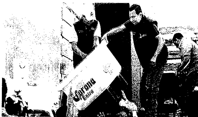
Para llevarse un puesto de periódicos, fue necesario romper el concreto que lo sostenía
