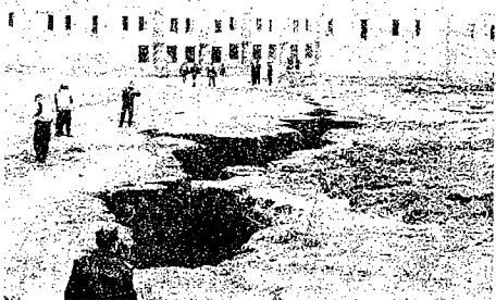
En peligro decenas de viviendas ante grietas y aguaceros.
