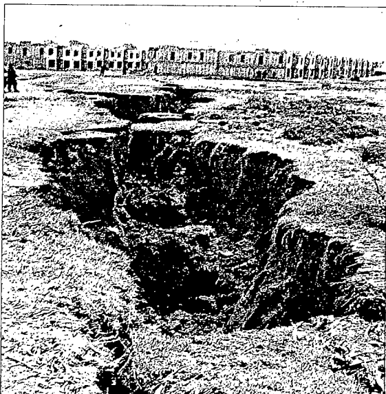
» FALLAS DEL subsuelo y la época de lluvias, generan condiciones de inestabilidad y riesgo como grietas y hundimientos.
