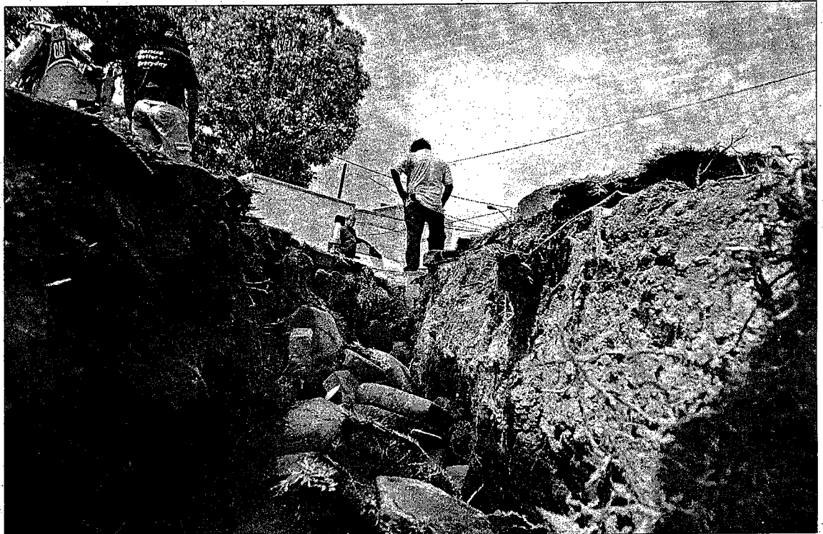
El reblandecimiento de tierra por una fuga de agua potable provocó que se formara una oquedad de 25 metros de largo por 60 de ancho, con profundidad de 60 centímetros, frente al número 40 de la calle Circunvalación, esquina con Emiliano Zapata, en la colonia Zona Urbana Ejidal Santa María Aztahuacán, delegación Iztapalapa. Personal del Sistema de Aguas de la Ciudad de México y de la Dirección General de Prevención evaluó la situación. A las 21 horas de ayer la fuga no había sido controlada ■ Foto Alfredo Domínguez
