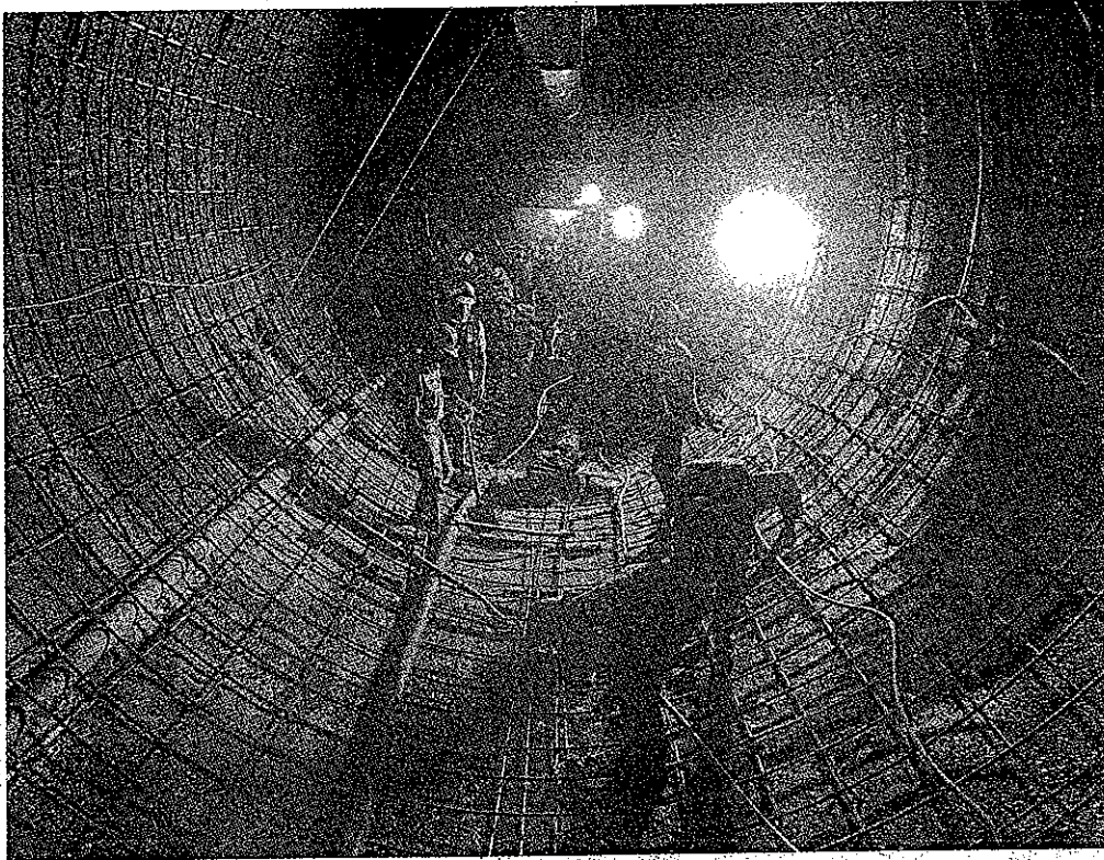
Las obras en el Drenaje Profundo se centran, además, en la reparación de más de 100 compuertas, que impedirán que aguas residuales lleguen a la superficie
